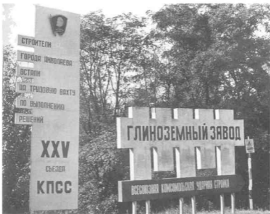
Початок будівництва МГЗ
