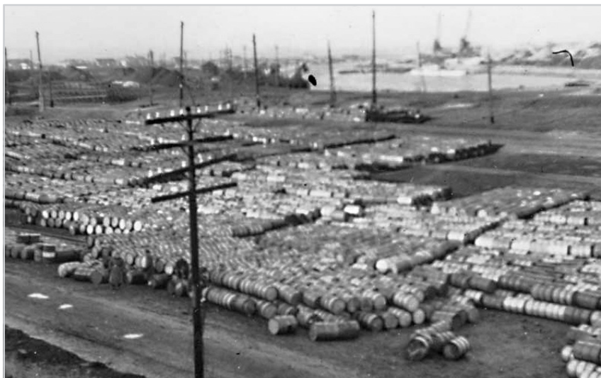
Склад бочок для спорудження мосту
