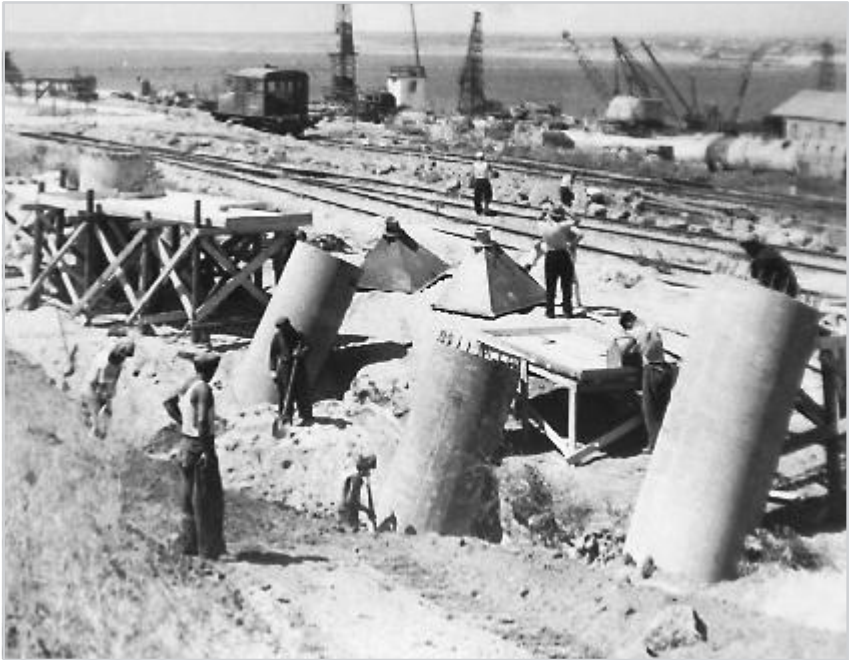
Йде будівництво берегових опор Варварівського мосту. Видно палі-оболонки
