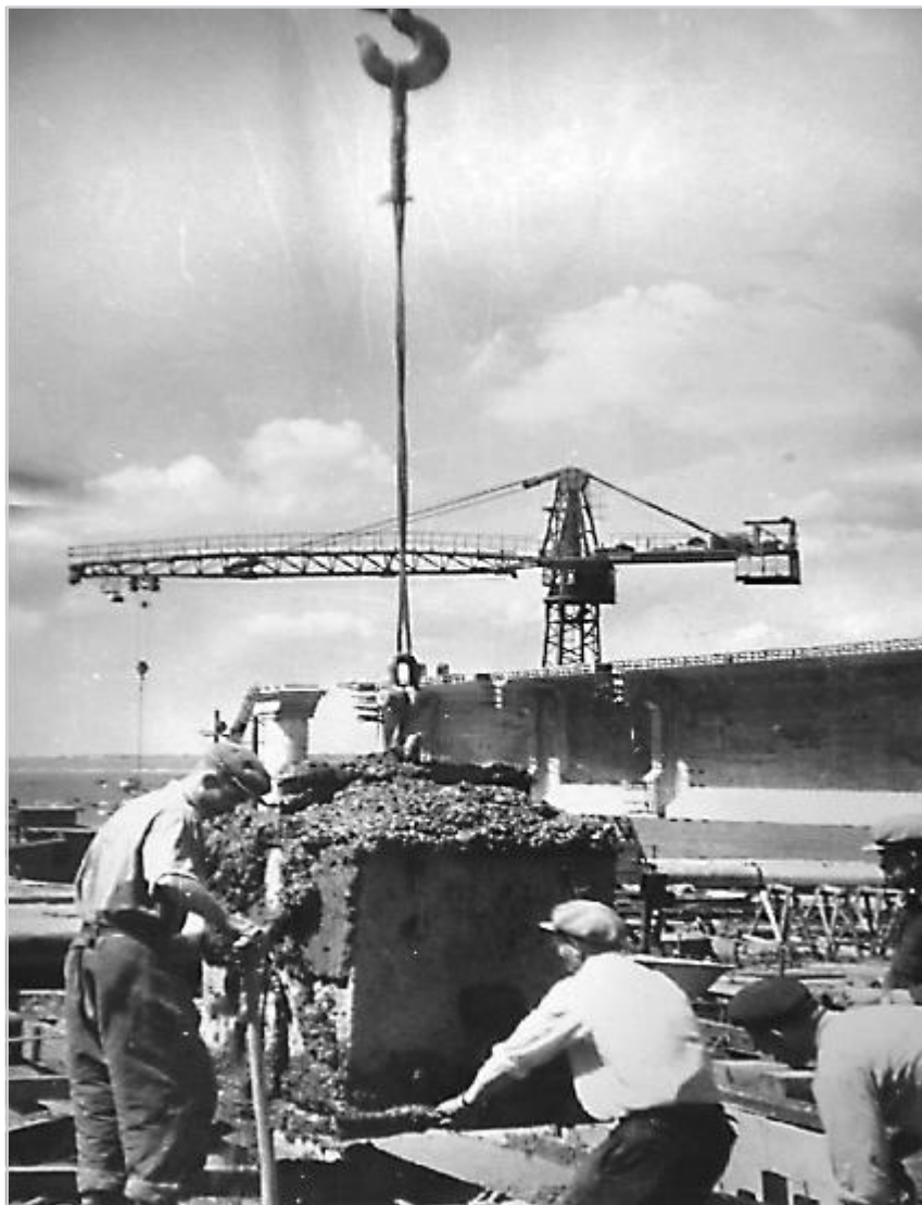
Бетонні роботи на стенді
