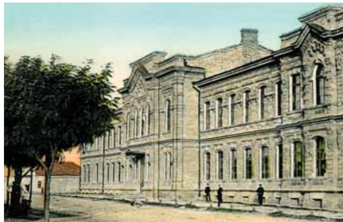
Здание среднего механико-технического училища (архитектор Е. А. Штукенберг), 1904 г.
