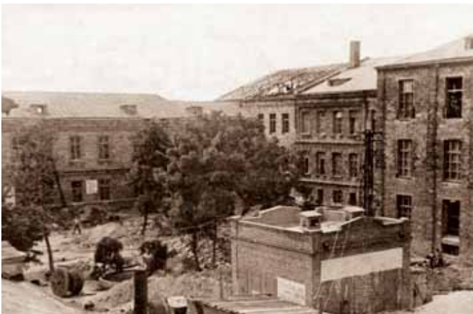
Разрушенное здание НКИ (вид со двора), 1944 г.
