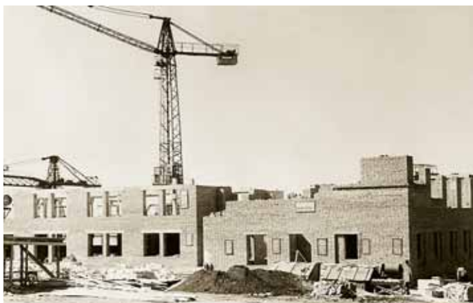
Строительство учебного корпуса на пр. Ленина, 1963–1964 гг.
