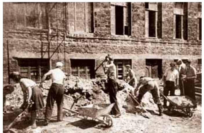
Восстановительные работы (вид со стороны фасада), 1946 г.
