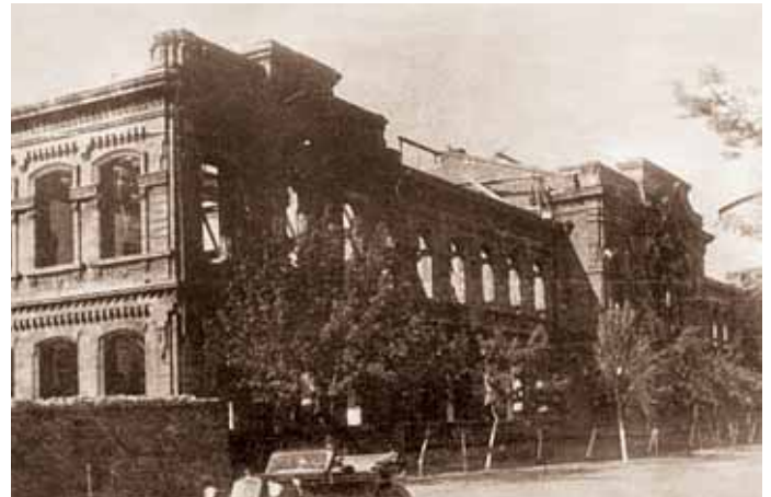
Разрушенное здание НКИ (вид с фасада), 1944 г.
